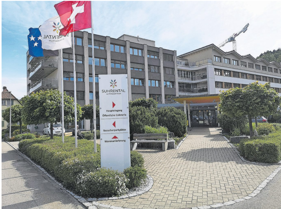
Es gibt einen Abbruch statt einer Sanierung: Das «Suhrental Alterszentrum» in Schöffland. Bild: uhg
